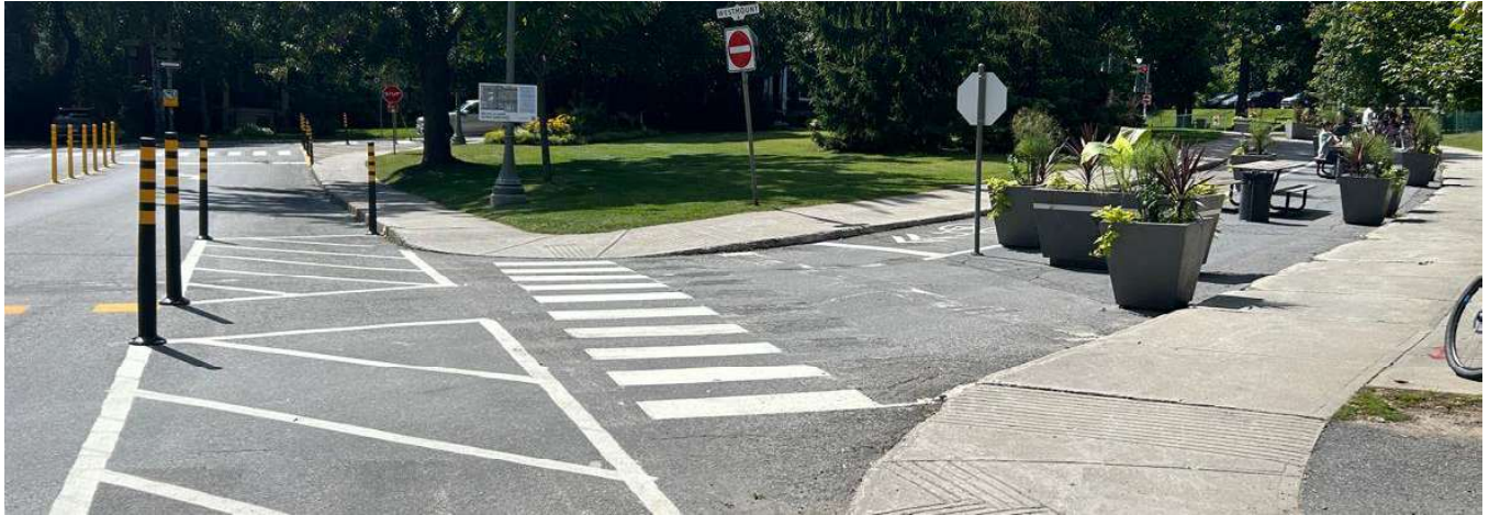
Figure 4.6 — Intersection Notre-Dame-de-Grâce/Westmount, vue depuis le coin « sud/ouest »
