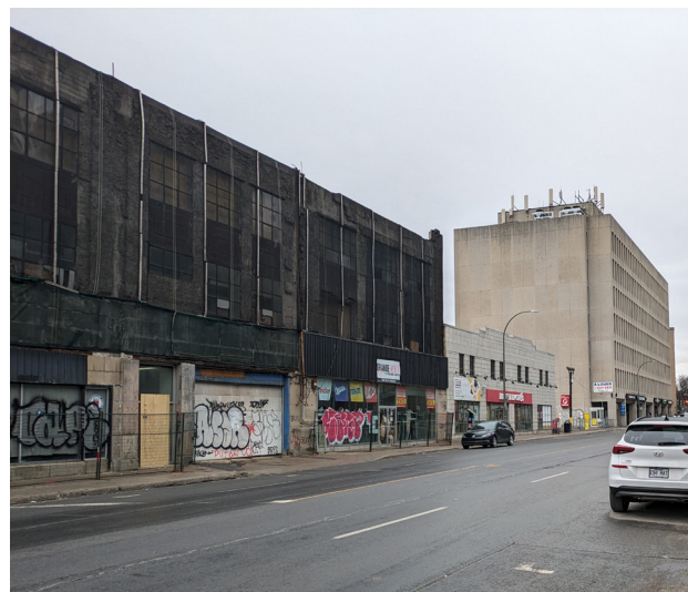
Façade partiellement démantelée dans la zone C11-24-10 (4030, rue Sainte-Catherine Ouest) Partially deconstructed facade in zone C11-24-10 (4030 Rue Sainte-Catherine Ouest)
