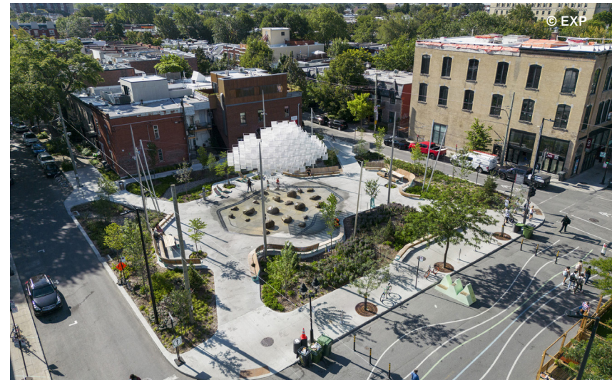
Gestion des eaux | Water management (Place du Macadam, Montréal)
