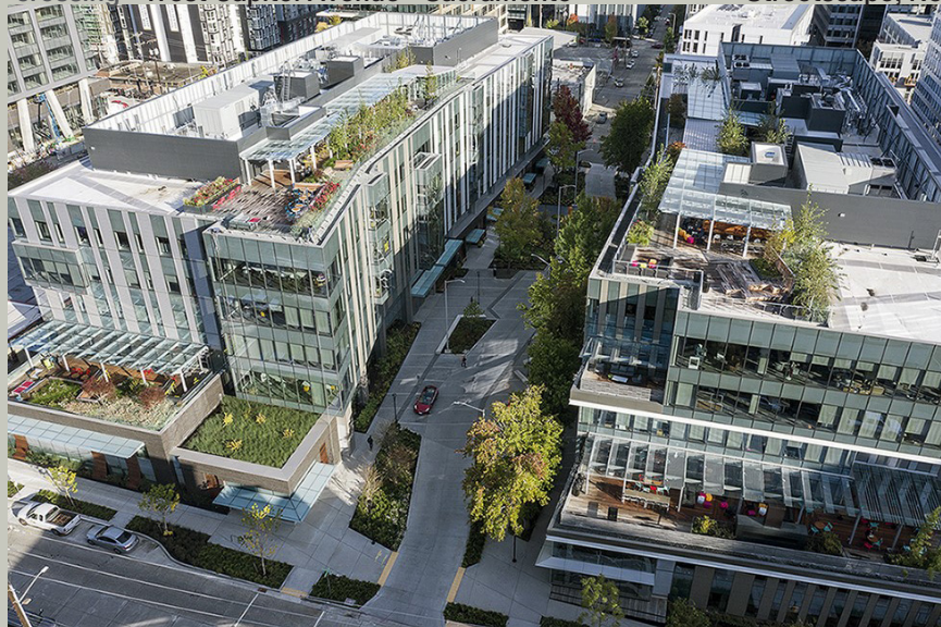
Nouveau lien partagé | New shared connection - Arbor Blocks, Seattle
