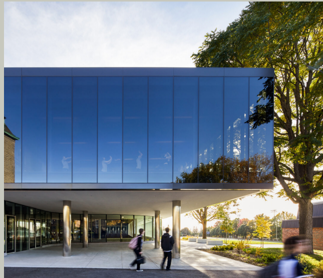
Équipement collectif | Public equipment - Collège Notre-Dame Gymnase, Montréal
