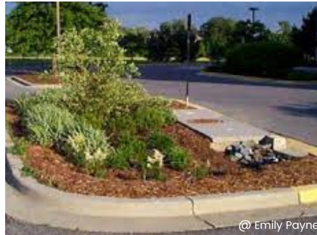
Bassin biorétention / Bioretention Area Australie
