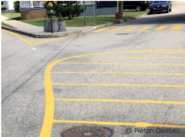
Marquage au sol / Road Markings Baie-Saint-Paul, QC
